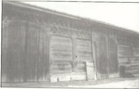
Stadel des vormaligen »Panhöllhofes« (Schiller), Beispiel für die frühere Holzbauweise (mit schönem Bundwerk)
