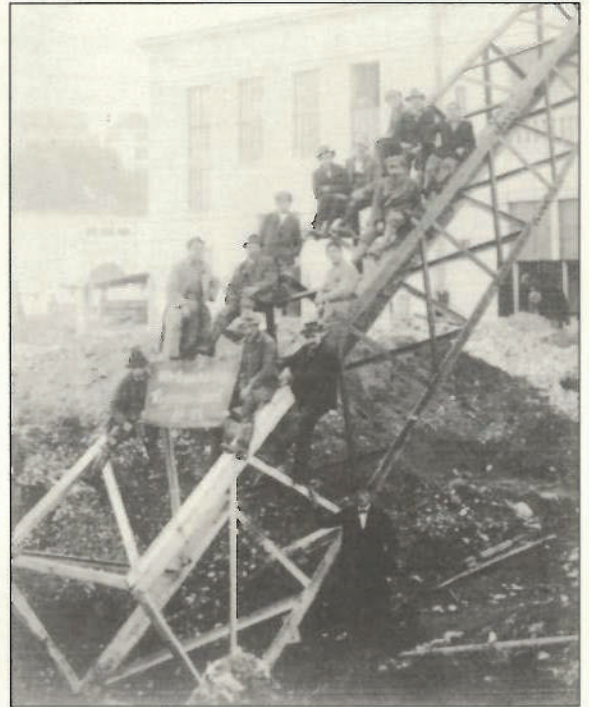
Errichtung der 100.000-Volt-Weitspannleitung Töging-Hart im November 1923
