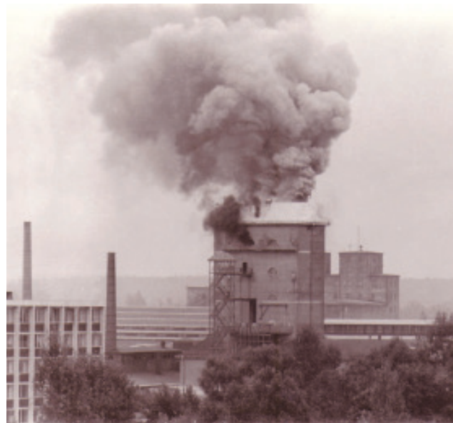
2. Oktober 1967: Das Silo brennt.
