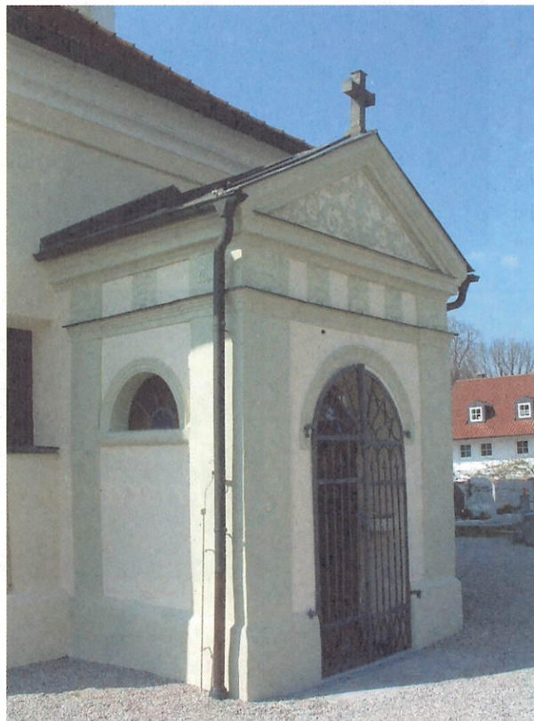
Die 1830 erbaute Kapelle an der Ostseite der Pfarrkirche St. Nikolaus zu Pleiskirchen diente für etwa ein Jahrhundert als Gruftkapelle der Familie Ueberacker von Klebing.
