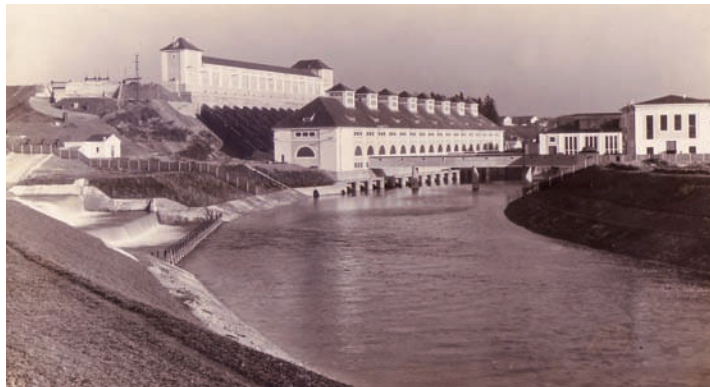
Der hohe Energiebedarf zur Aluminiumherstellung machte einen 20 km langen Kanal von Jettenbach notwendig. Am Kraftwerk in Töging erreichte man ein Wassergefälle von 33 m. Im Dezember 1924 wurden die ersten Elektrolyseöfen eingeschaltet und das erste Aluminium gewonnen. Das Foto von Wasserschloss und Krafthaus entstand 1925.
