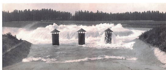
Diese Aufnahme vom 31.5.1925 zeigt den Energievernichter in Tätigkeit, links der Unterwasserkanal.
