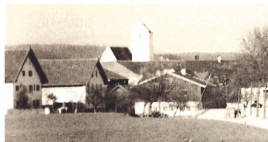
Blick vom noch im Bau befindlichen Kanalberg auf den Oellerhof. Rechts im Bild noch zu erkennen das Nebengebäude Haus Nr. 39 ½, in dem Johann Münch wohnte und dort die Poststelle eingerichtet hatte. Links im Bild der Mojerbauer.
