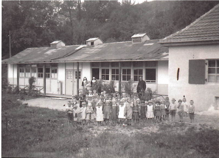
Etwa vom Jahr 1937 stammt diese Aufnahme, die noch die Baracke zeigt, die Werksdirektor Wilhelm Hübsch der Pfarrei für die „Kleinkinderbewahranstalt“ schenkte. Das kleine Gebäude daneben entstand etwas nach 1930. Es hatte nur einen Raum und wurde, so erinnert sich ein ehemaliges Kindergartenkind, für Spiele und zum Turnen benützt. Nach 1945 durften auch die Tischtennisspieler zeitweilig darin üben, ebenso die Theatergruppe der Pfarrjugend. 1955 verschwand dieses Ensemble und machte einem neuerrichteten Kindergarten Platz.
