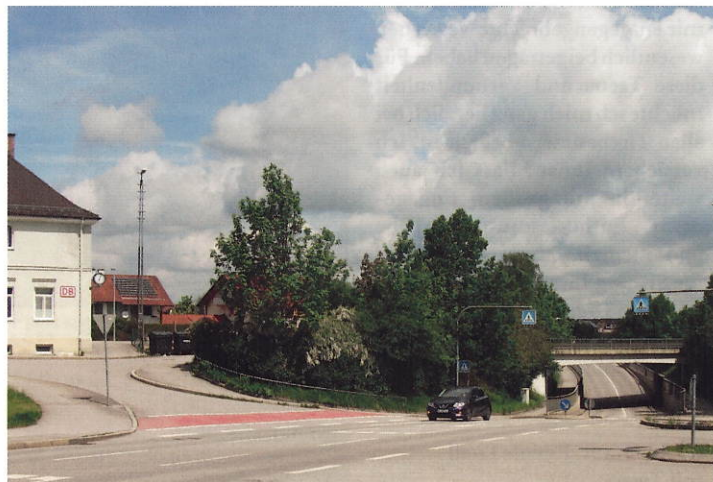
Die Unterführung der Bahnlinie München-Simbach im Zuge des Ausbaues der Weichselstraße wurde 1996 freigegeben
