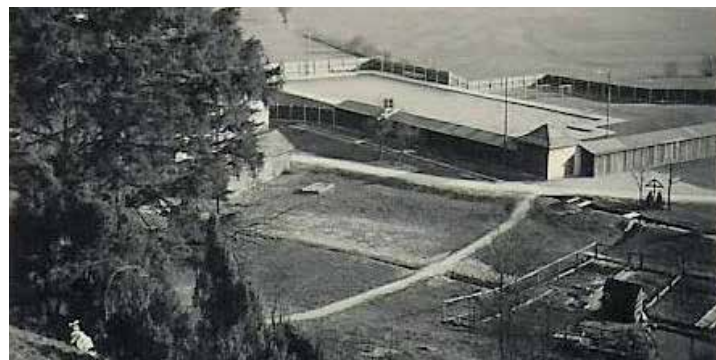
Blick vom Hang auf das bereits fertig gestellte Schwimmbad. Rechts vom Feldkreuz, das auch heute noch steht, war das Vorwärmebecken (nicht mehr im Bild)
